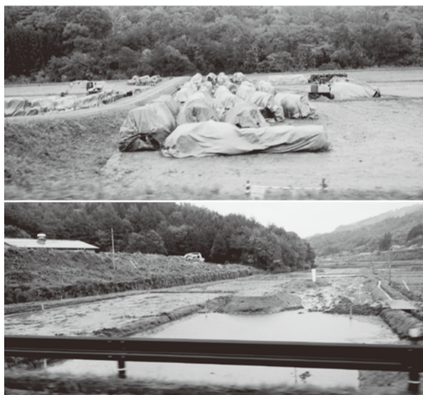
(上) 飯館村の除染作業の田んぼ。剥ぎ取った土はフレコンバックに入れ、ブルーシートでおおわれ、搬出先はまだ決まっていない。(下) 飯館村。家の後ろが山となつて除染もままならない。
